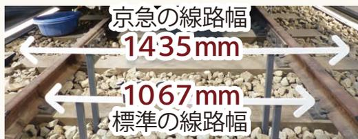
**線路の幅** 東急電鉄も「1067ミリ」です。対して、京急電鉄や新幹線は、世界的な標準サイズ「標準軌」である「1435ミリ」です。1067ミリより幅が広いので「広軌」と呼ぶこともあるようです。
