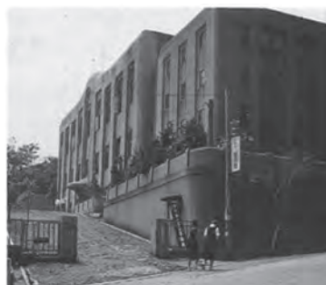
〈横浜市図書館外観1958（昭和33）年〉
