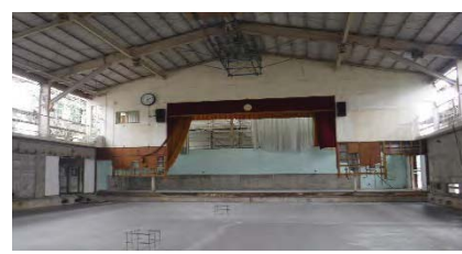
小学校体育館の改修工事
