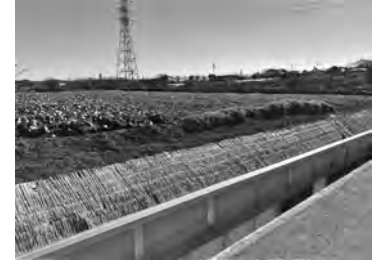
土砂流出対策を行った農地
