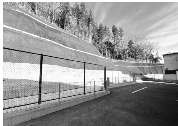
恩田東部特別緑地保全地区 ※法面は植栽基材吹付により緑化
