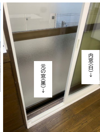
↑窓の断熱化（内窓の設置）
