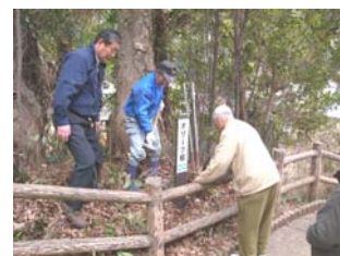
【坂道愛称名看板設置】
