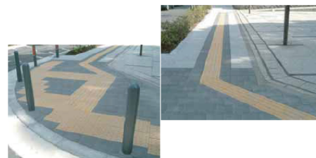
視覚障害者誘導用ブロックの設置例
