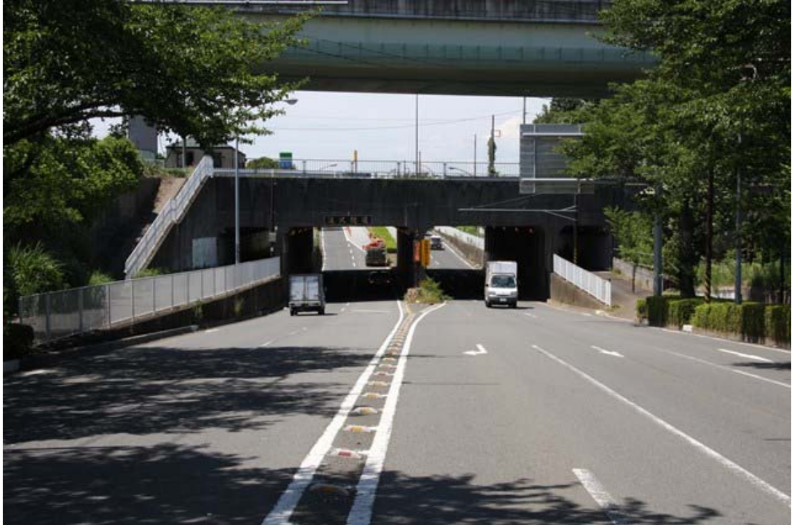
緑区方面側から
