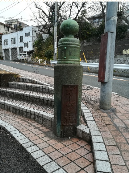
残されたガーデン橋親柱（現在）
