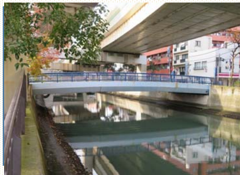
共進橋下流より望む（現在）
