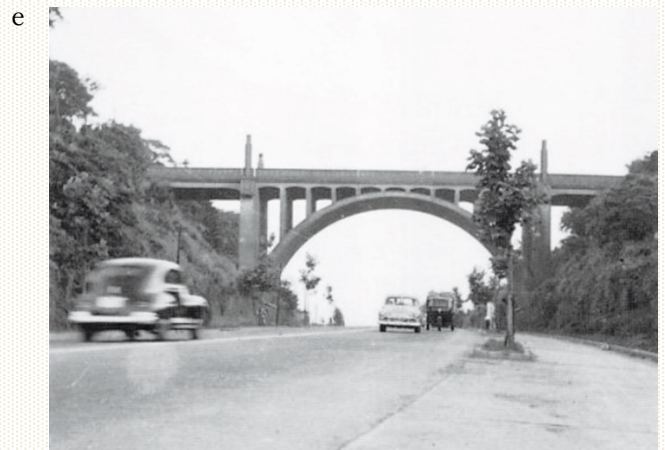
昭和25年(1950)の第二京浜国道から望んだ響橋 この当時は転落防止柵がついていないため、地覆上部にある4つの柱が今以上に強調されて見えます。
