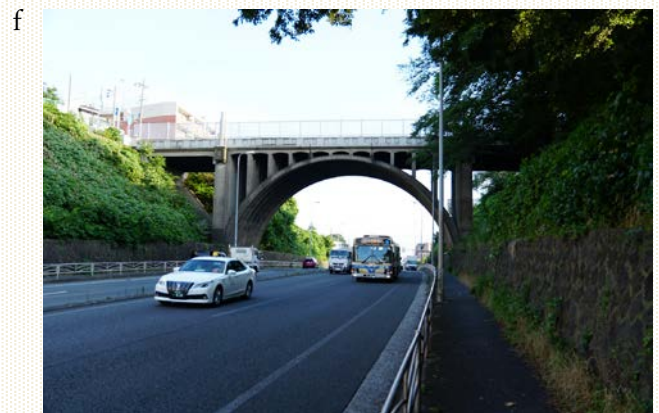
現在の第二京浜国道から望んだ響橋
