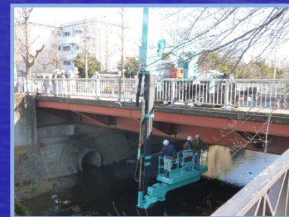
城山橋（栄区）／橋梁点検
