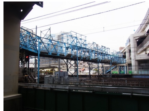
内海川跨線人道橋(西区)
