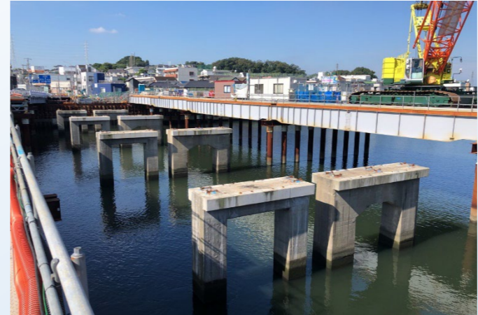
躯体切断撤去工
