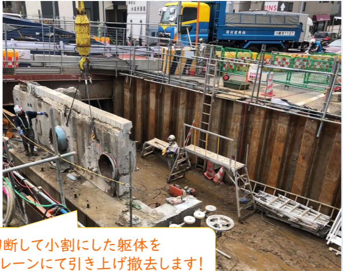
躯体切断撤去工
