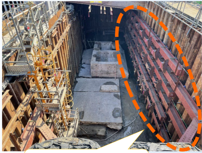
土留めアンカー設置状況
