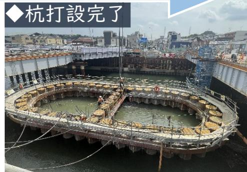
河川内の工事は雨の少ない期間（非出水期（11月～5月））で施工するため、非常にタイトなスケジュールで「鋼管矢板井筒基礎」と呼ばれる杭、**計48本の打設を完了しました!!!**
