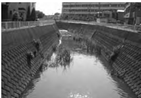
■コンクリート護岸（舞岡川 戸塚区）
