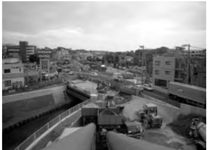
■整備中の平戸永谷川 赤関橋（戸塚区）
