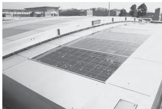
西谷浄水場覆蓋
