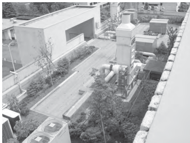
西谷浄水場屋上
