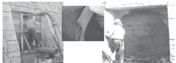
高流動埋戻材施工例
