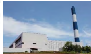
ごみ焼却工場(都筑)
