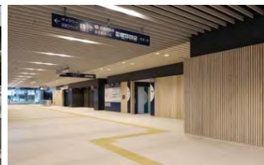
公共建築物の省エネ化 (南区総合庁舎の木質化整備)
