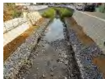
護岸整備された河川(和泉川)
