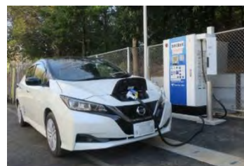
急速充電設備（都筑区）
