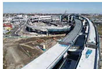
整備中の横浜北西線（横浜港北 JCT）
