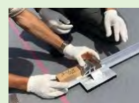
必要な寸法で切った角材を活用し、作業を簡略化
