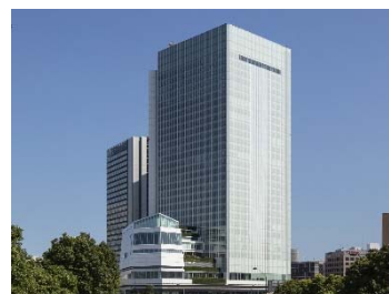
横浜市役所新庁舎（中区）
