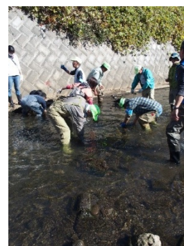
石積み水制工の補修作業の様子（旭区）
