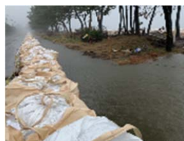
大型の土嚢を積んで背後地への浸水を阻止 (台風19号襲来時の金沢区福浦・幸浦地区)
