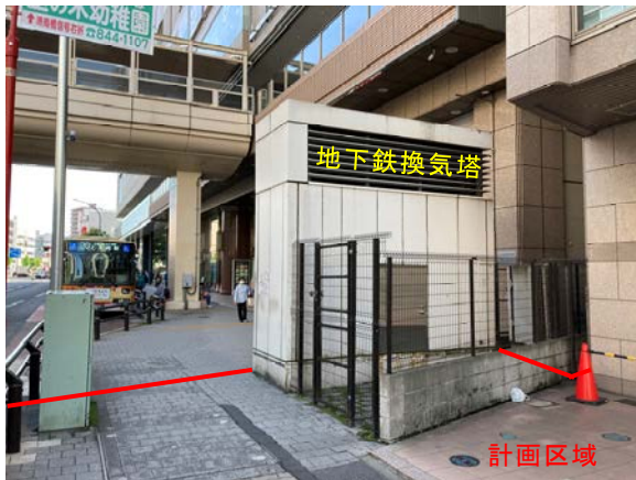
⑥ 地下鉄換気塔の状況 (撮影日：令和4年5月18日)
