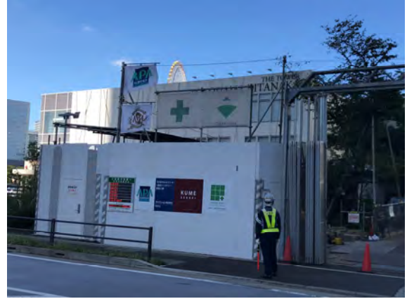
写真 3.2-8 仮囲いの設置状況
