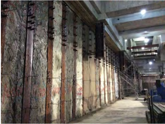
写真 3.2-19 SMW山留壁の構築状況
