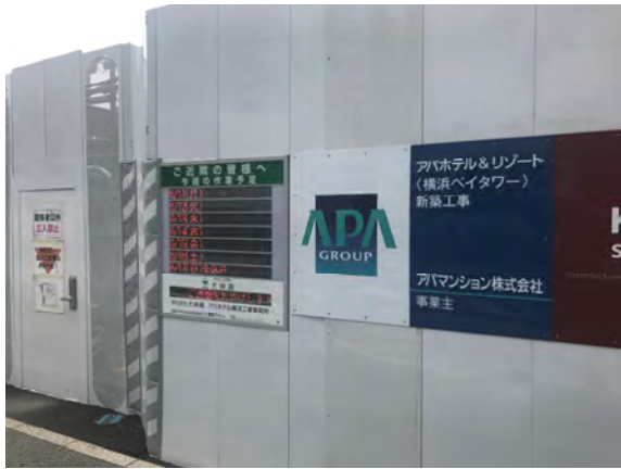
写真 3.2-25 お知らせ看板の設置状況
