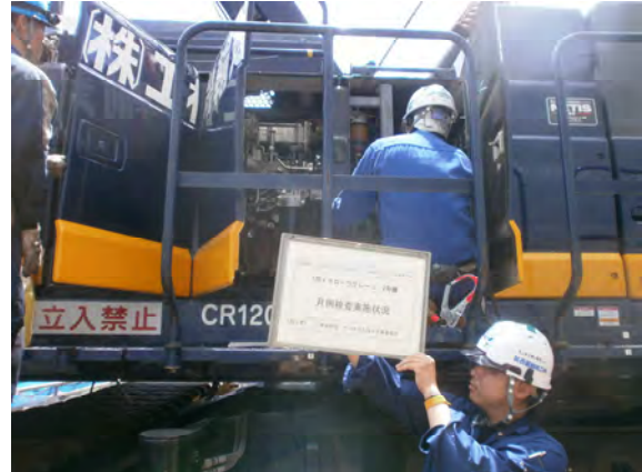
写真 3.2-14 月例点検の状況
