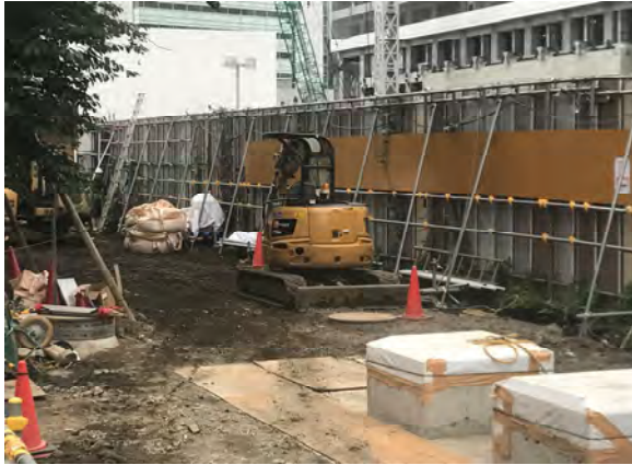
写真 3.2-13 敷地境界付近での 小型重機の使用状況
