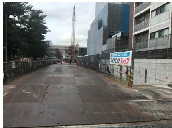
写真 3.2-18 段差のない敷鉄板の設置状況
