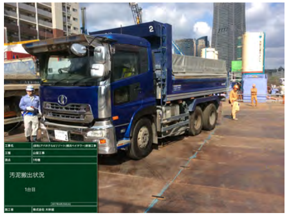
写真 3.2-10 搬出車両の状況 (飛散防止シート設置)
