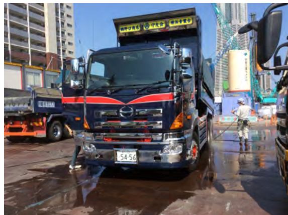
写真 3.2-11 搬出車両の状況 (タイヤ洗浄)
