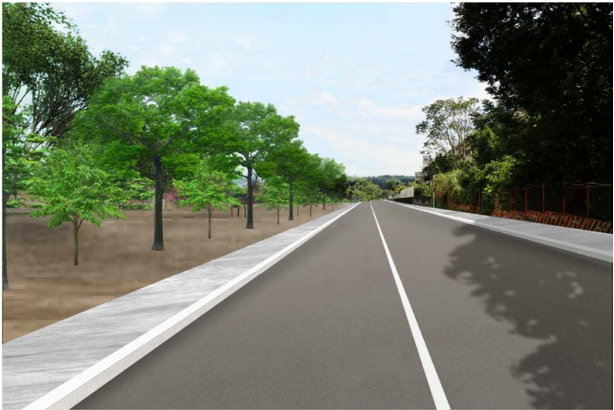
写真 6.11-5(2) No. 23 深見第 228 号線(対象事業実施区域 南側) (整備前)
