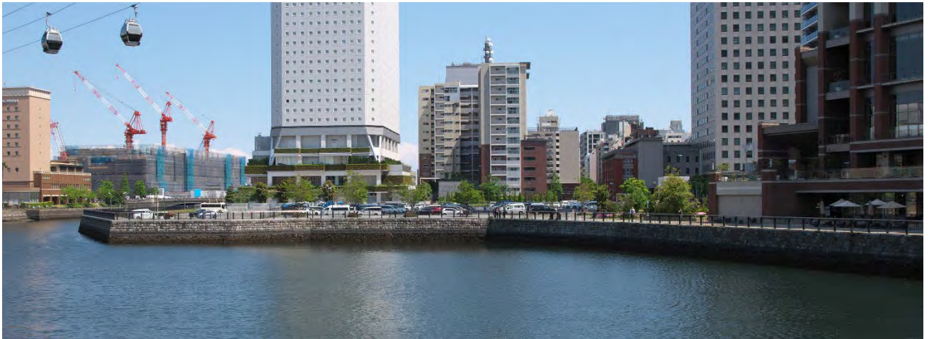
写真 5-1 対象事業実施区域及びその周辺の護岸の状況
