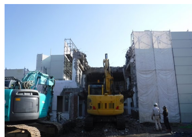
解体工事現場の例 ※写真の一部を加工しています
