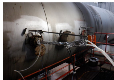
特定施設の排出ガス測定の様子 (ダイオキシン類)
