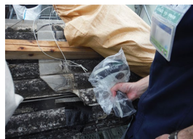
改修工事への立入検査における 石綿含有建材の確認 （アスベストアナライザーを用いた 簡易分析の様子） ※写真の一部を加工しています
