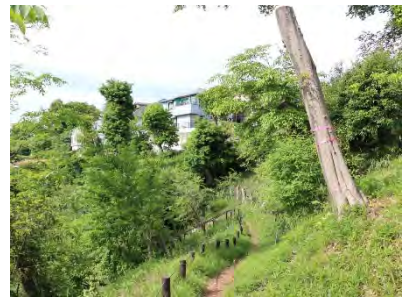
斜面の安全対策として萌芽更新を行った樹林地 上：作業前、下：作業後
