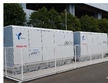
自立型水素燃料電池システム
