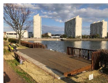
ふなだまりウッドデッキ（金沢区）
