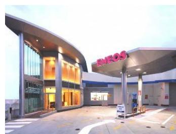
綱島水素ステーション (港北区)
