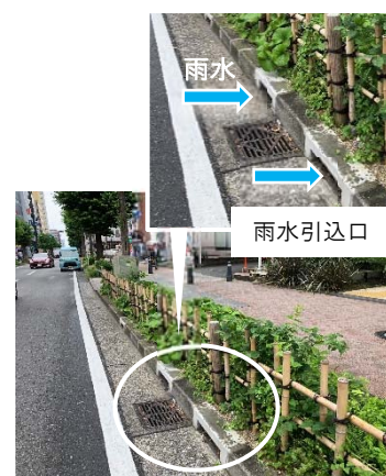
雨水を引き込む植栽帯（港北区）
