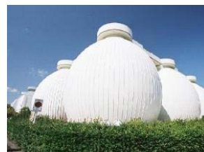
図 北部汚泥資源化センターの消化タンク
