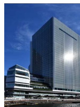
横浜市役所新庁舎（中区）
