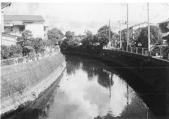
J2 侍従川 六浦二号橋
