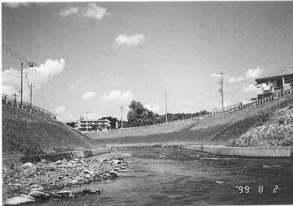
T 1 鶴見川 水車橋
