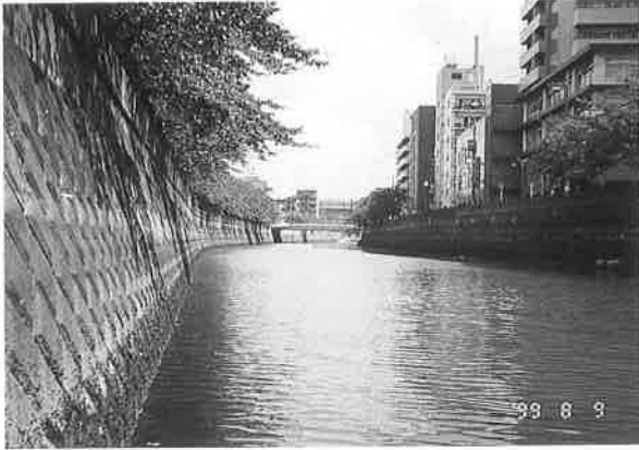
○ 4 大岡川 井戸ヶ谷橋
