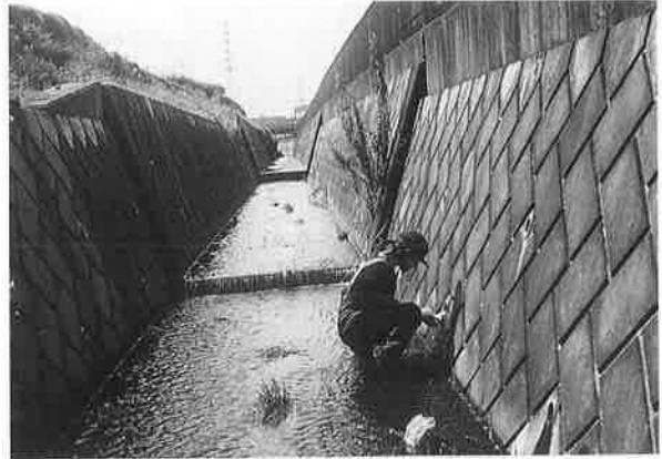
T 4-2 鶴見川・大熊川 掘込橋
