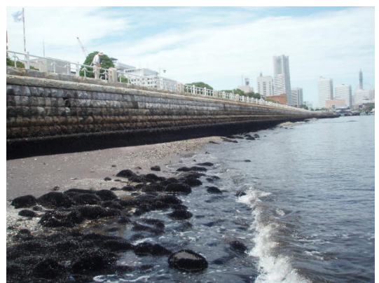
写真1(3) 山下公園の護岸状況
