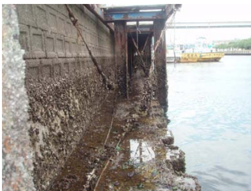
写真1 (7) コンクリート垂直護岸
