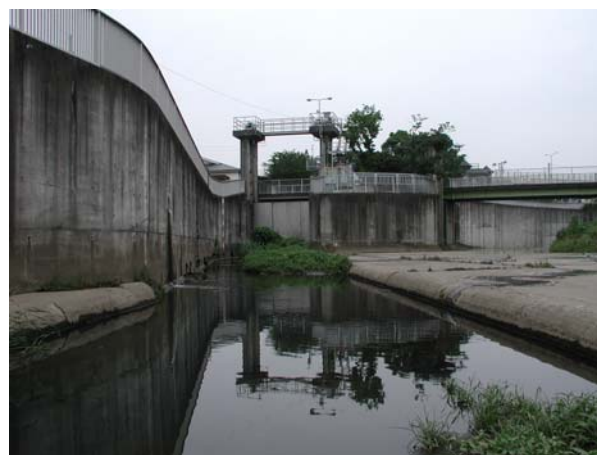
写真－２ 日野川の分水路取水庭
