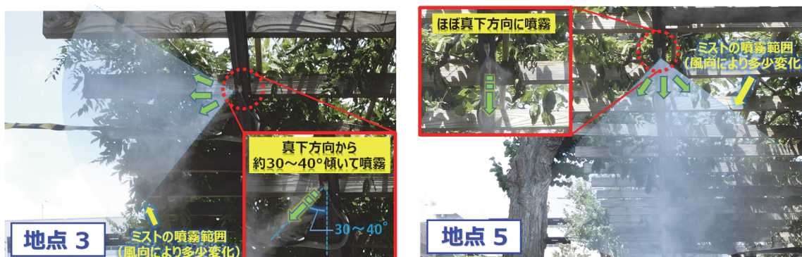
図4 ミストの設置状況
