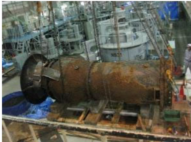
再整備前のポンプ設備
