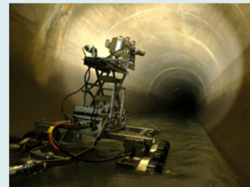
中大口径管の調査状況
