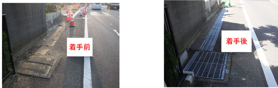
既存コンクリート蓋をグレーチング化した事例 着手前（左） 着手後（右）
