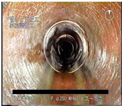
更生前の下水道管
