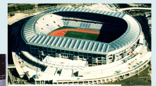
日産スタジアム↑ ←ヒートポンプ
