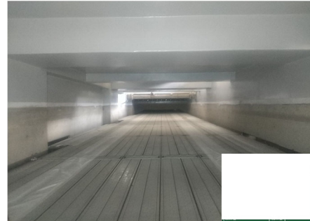
最初沈殿池での防食被覆更新（左：施工前、右：施工後）
