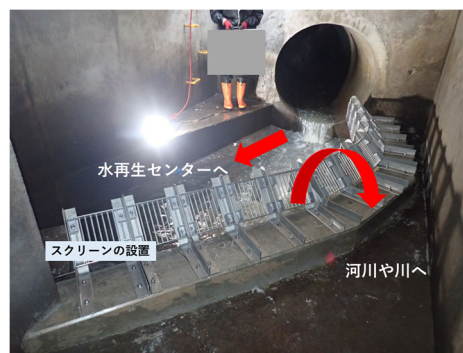
雨水吐の改良状況
