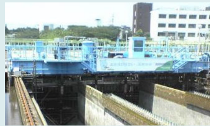
最終沈殿池の採泥機
