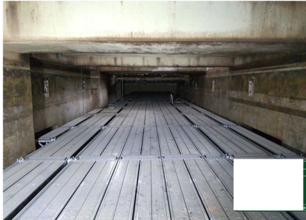
最初沈殿池での防食被覆更新（左：施工前、右：施工後）
