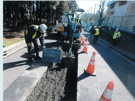
布設替の施工状況
