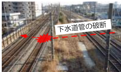
鉄道軌道下の下水道管の耐震化
