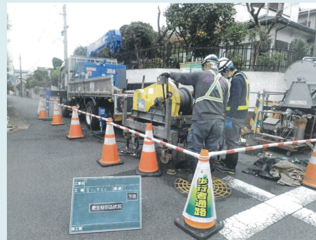
管更生の施工状況
