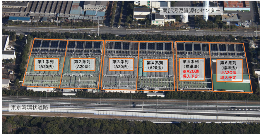
高度処理施設（A2O法）の導入例（金沢水再生センター）
