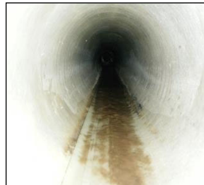
更生後の下水道管
