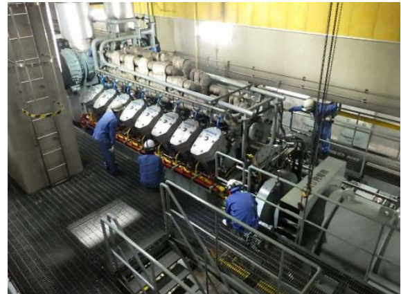
自家発電機設備の点検
