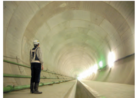
直径6.5mの下水管
