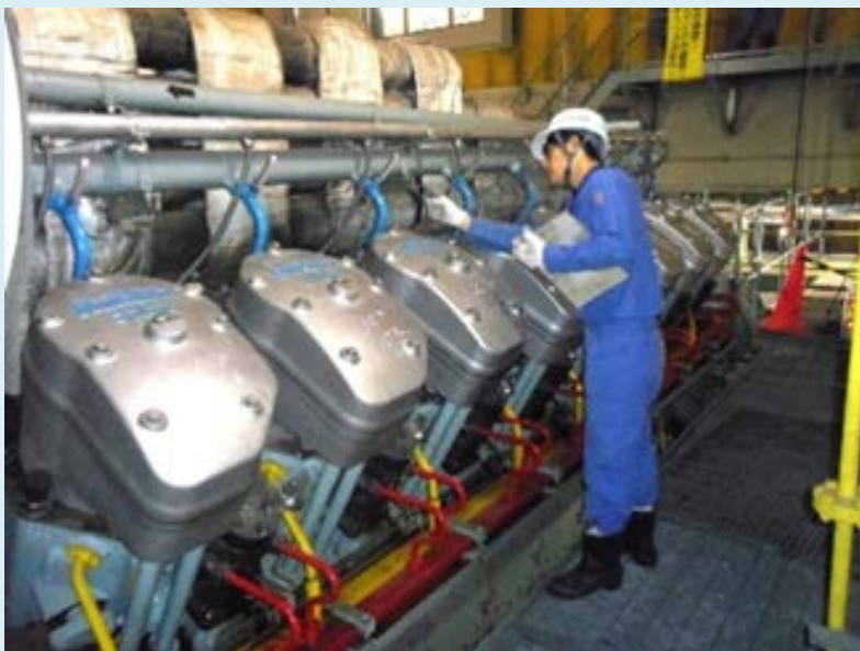
水再生センター施設・設備の点検
