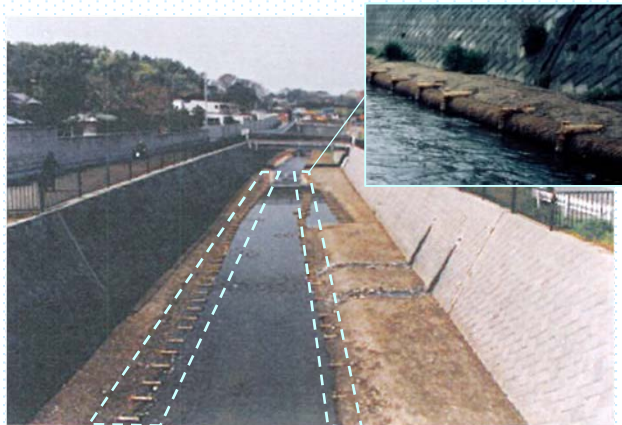
低水路整備施工直後の様子（本郷橋付近）
