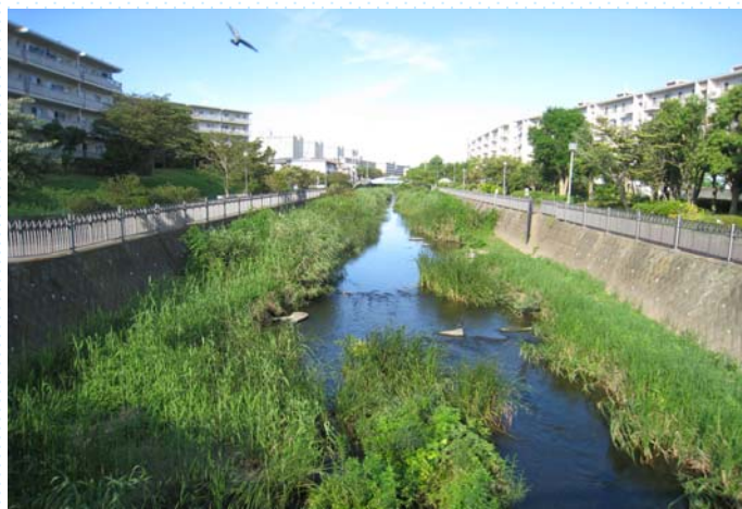
低水路整備後の様子（海里橋付近）
