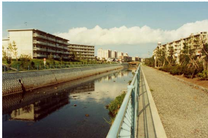
河川改修後の様子（昭和56年 海里橋付近）
