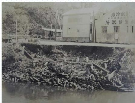
P 前田橋下流の石積み護岸の崩壊状況
