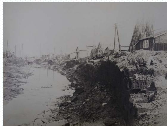
N 一本橋下流の石積み護岸の崩壊状況
