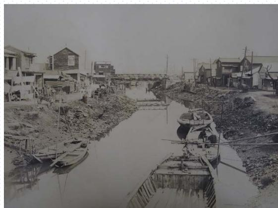
M 長者橋下流の石積み護岸・道路の壊滅状況
