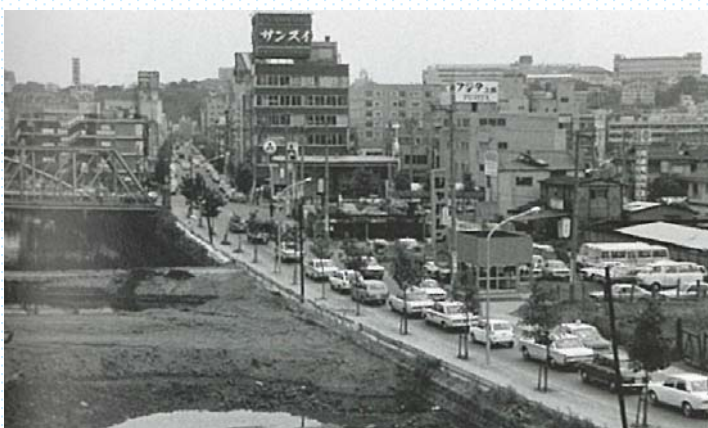
港橋付近の派大岡川埋立工事（1971昭和46年）
