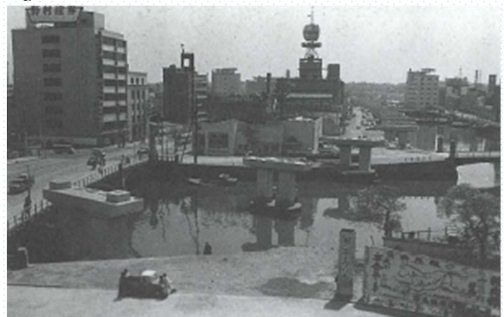
国鉄根岸線橋脚工事(大江橋付近)、手前は大岡川、右奥は派大岡川（1961昭和36年）
