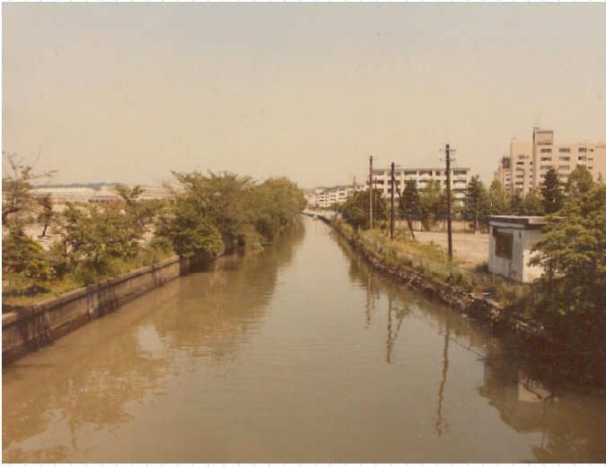
河川改修前（新瀬戸橋上流側 昭和58年）
