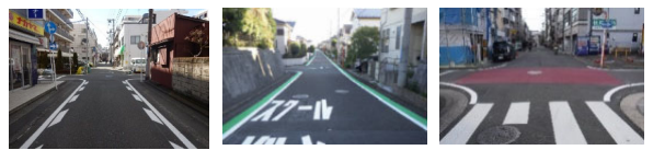
区画線(減速ドットマーク) グリーンベルト 交差点カラー化
