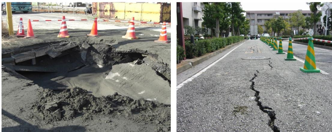
図 2-28 東日本大震災後の市内の被害状況
