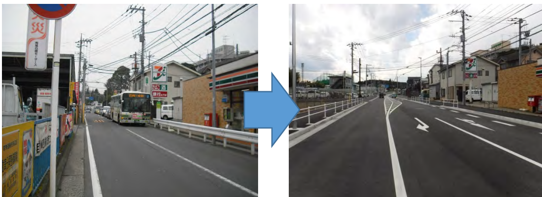
図 5-28 道路の拡幅整備（旭区）
