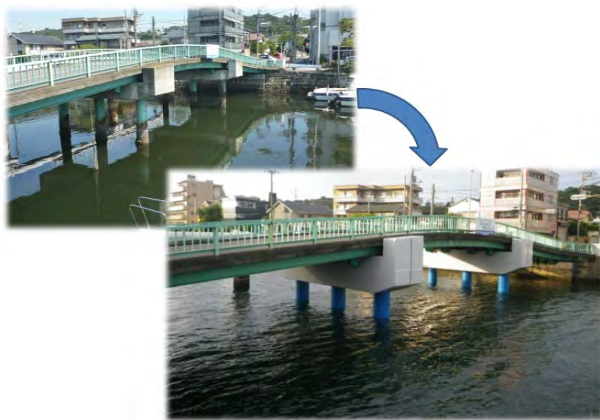
図 5-52 橋梁の耐震化（磯子橋）
