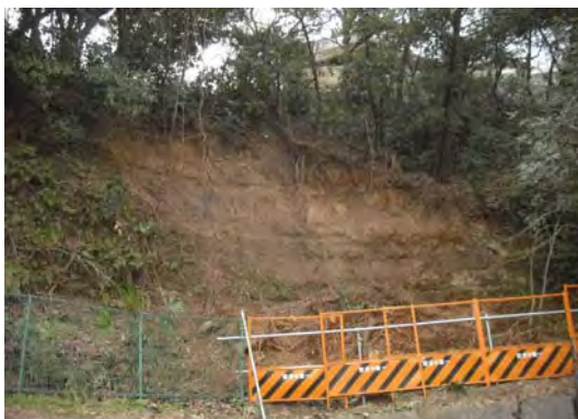
安全対策が必要な斜面地
