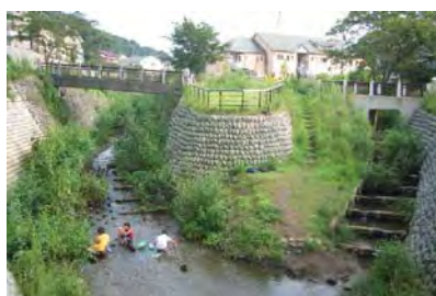
親水や自然環境に配慮した河川
