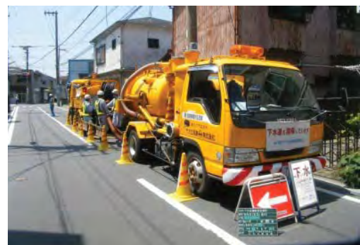
吸引車による下水道管の清掃
