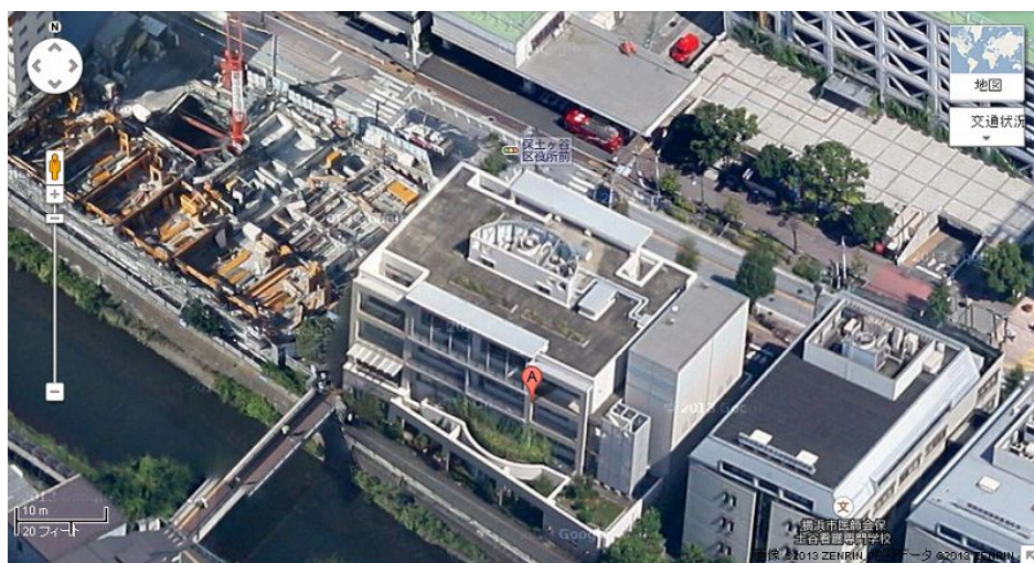
保土ヶ谷区・星川地域ケアプラザ
