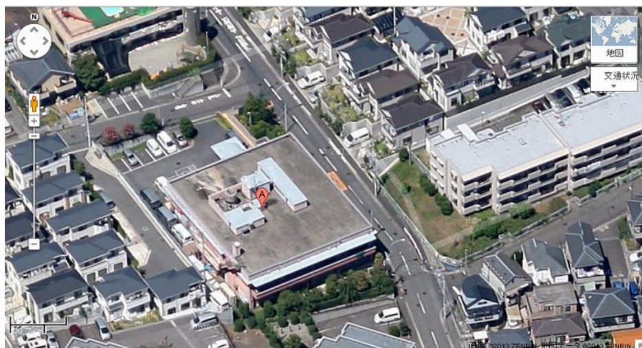
青葉区・さつきが丘地域ケアプラザ
