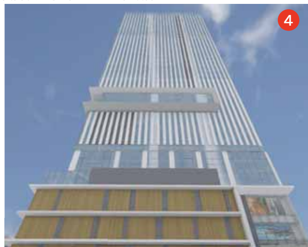
関内駅港町地区から望む高層部
