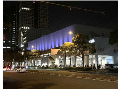
建物正面の壁面を限定的に演出 (びあアリーナ)
