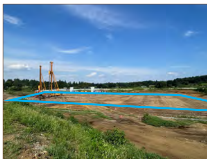
【②相沢川調整池の地盤改良工事】
