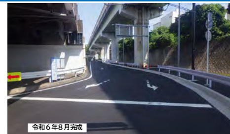
令和6年8月完成
