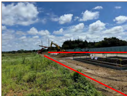
【①道路・上下水道の整備】
