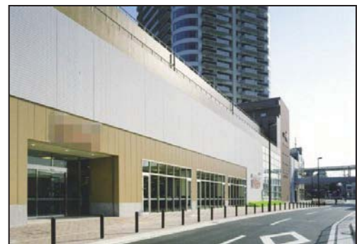
写真 駅南口線路沿いの道路
