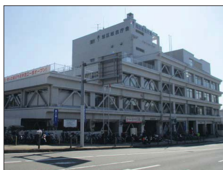
写真 旭区総合庁舎
