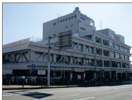
写真 旭区総合庁舎
