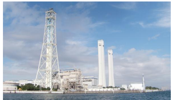
火力発電所（大黒ふ頭地区）
