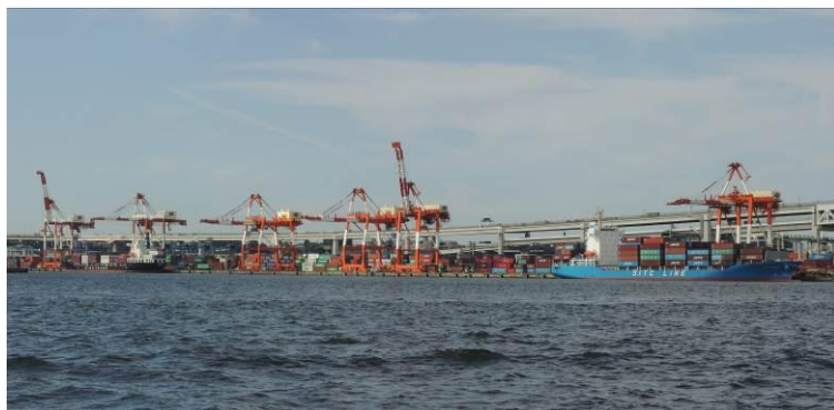
本牧ふ頭のガントリークレーン
