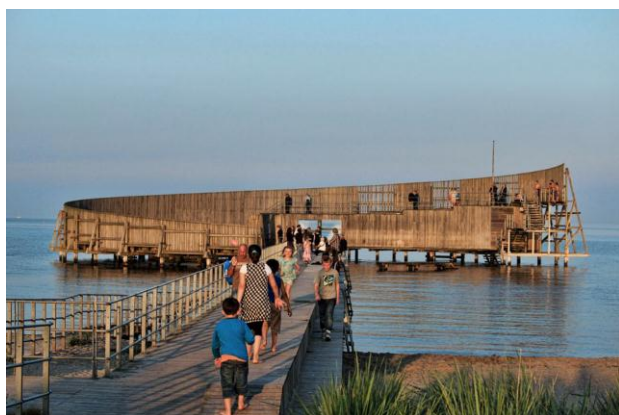
水上に設けられた海水浴用のデッキテラス （カストルupp/デンマーク）
