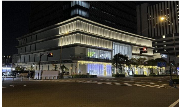
来街者を迎えるゲート空間として建物の正面を際立たせ、それ以外の部分は落ち着いた光とし、メリハリのある照明としている（村田製作所みなとみらいイノベーションセンター）
